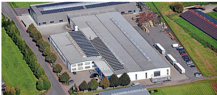
Großzügig dimensioniert: Der Hauptsitz mit Büros und Werkshallen wurde 2006 komplett nach Spredda verlegt. Foto: Renken
